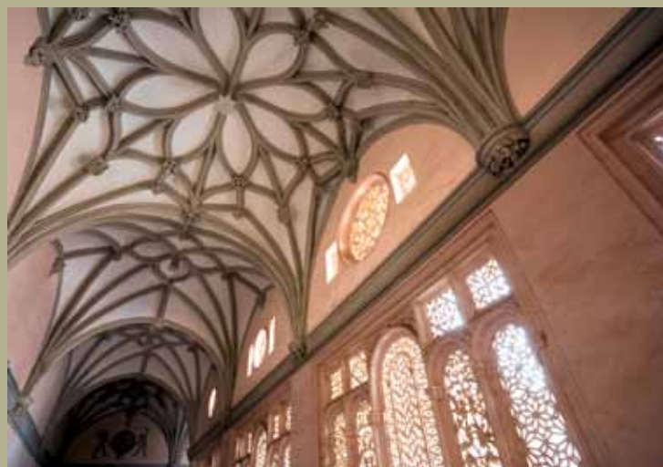
Bóvedas y celosías del claustro
