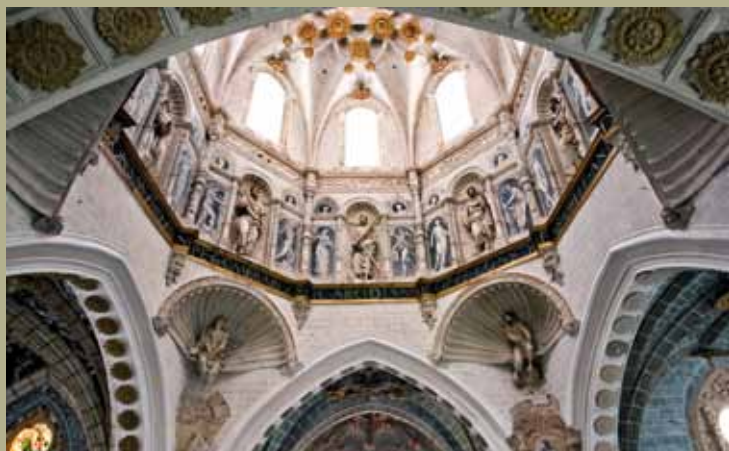
Interior del cimborrio
