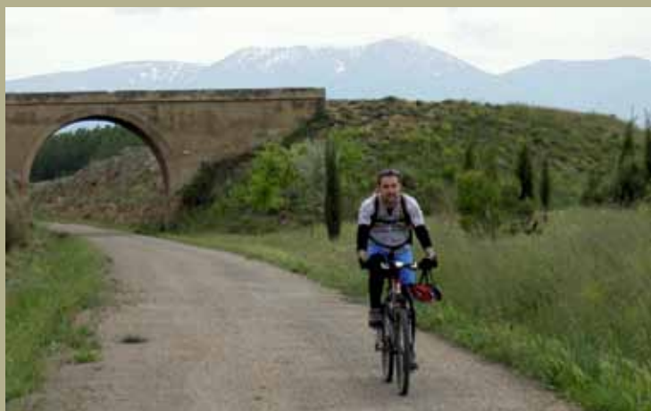
Un tramo de la vía verde
